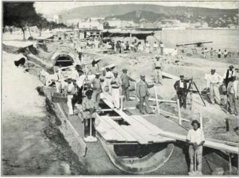
NICE. CONSTRUCTION DU GRAND COLLECTEUR SOUS LA PROMENADE DES ANGLAIS LE LONG DE LA MER, AVEC MUR DE DÉFENSE Débris de fondation, maçonnerie et grès droits des égouts en chaux brulée. Voies des égouts, dallage de la Promenade et amont Portendu. M. MICHEL, ingénieur en chef des Travaux et Éclairage Construction du grand collecteur Promenade des Anglais, coupure de presse, [1900-1910].
