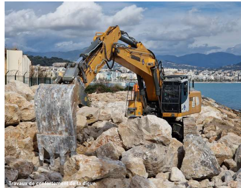
Travaux de confortement de la digue.
