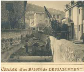
CURAGE D'UN BASSIN DE DESSABLEMENT Archives Nice Côte d'Azur (fonds Eau d'Azur)
