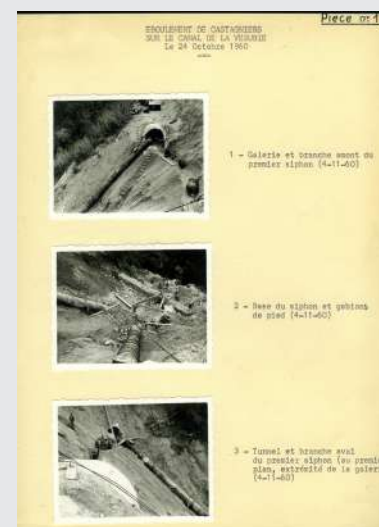
Dossier photographique de l'éboulement à Castagniers sur le Canal de la Vesubie en 1960.
