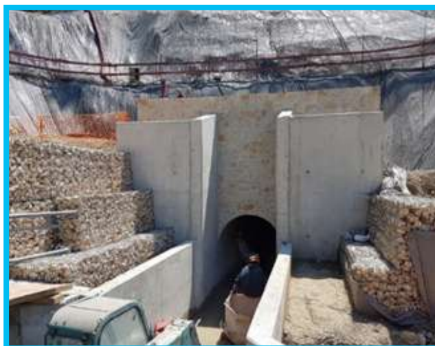
Accès du canal de la Vésubie dans le tunnel réhabilité de la Roquette-sur-Var
