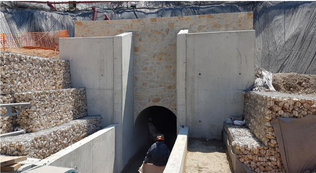
Photo : accès du canal de la Vésubie dans le tunnel réhabilité de la Roquette-sur-Var
