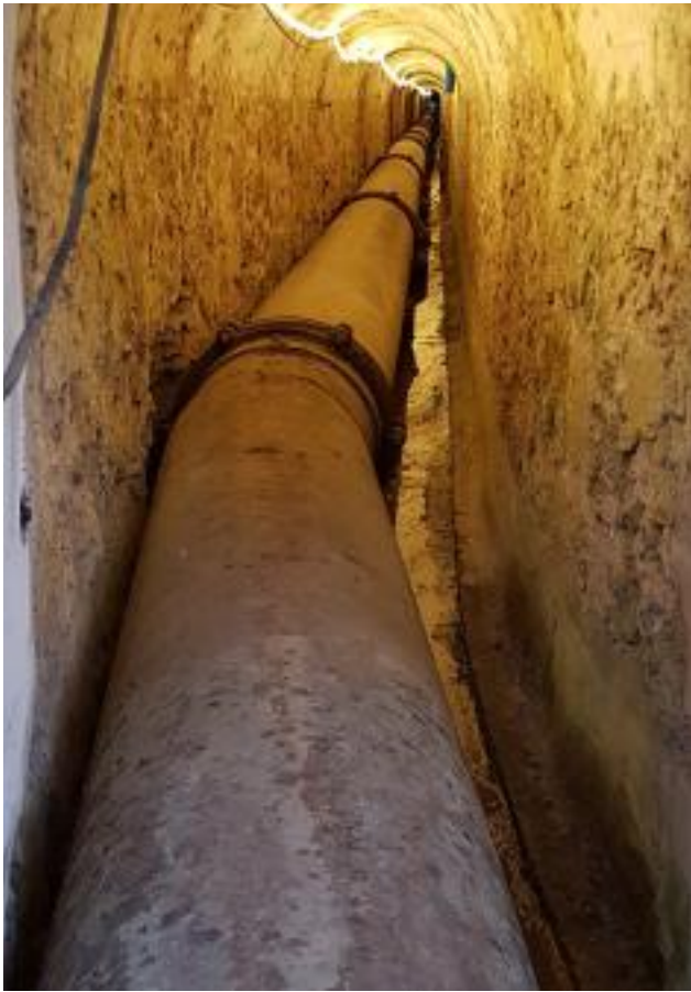
Tuyau Eternit existant Diamètre 500
