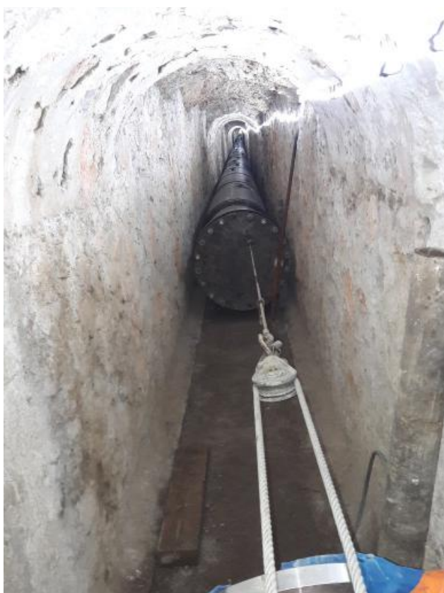
Mise en place de la nouvelle conduite par un élingage par treuil horizontal
