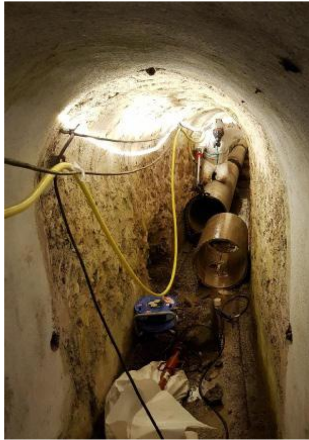
Dépose de la conduite existante
