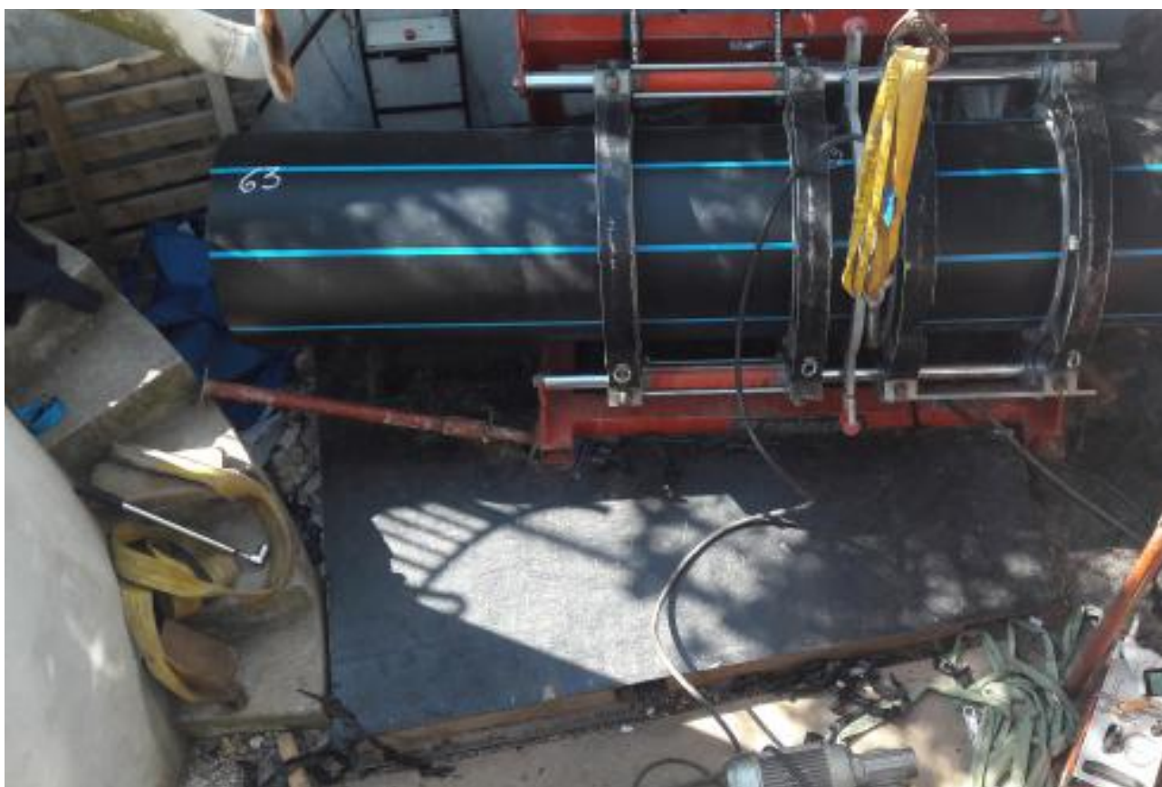
Assemblage des tubes PEHD par soudure au miroir
