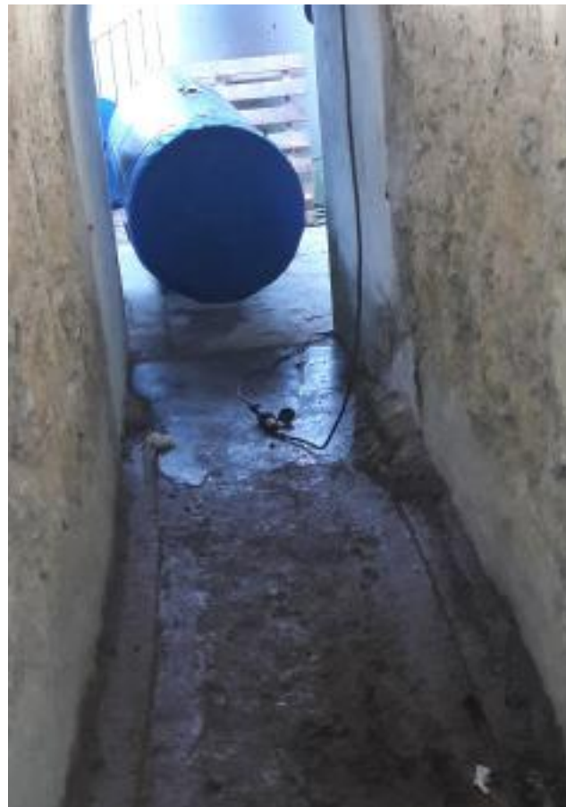
Puit d'entrée pour la nouvelle canalisation
