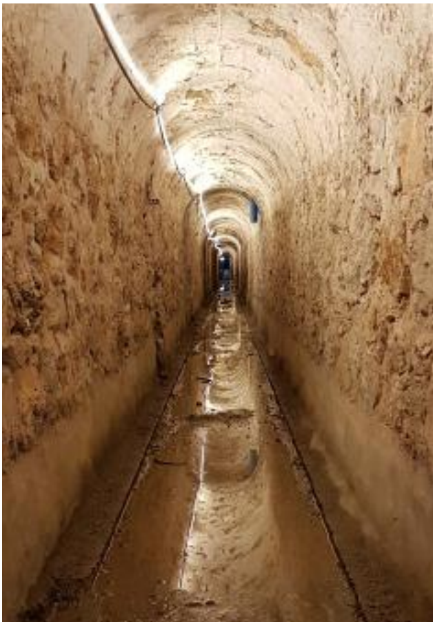
Nettoyage de la galerie
