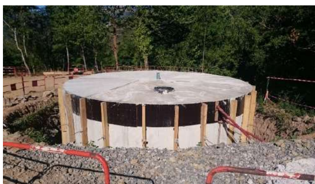
Réservoir des vignes en cours de construction
