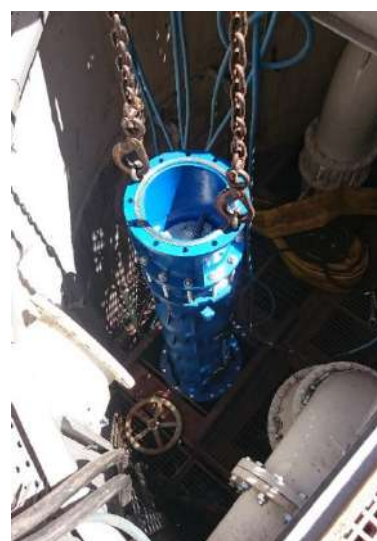
Installation d'une pompe
