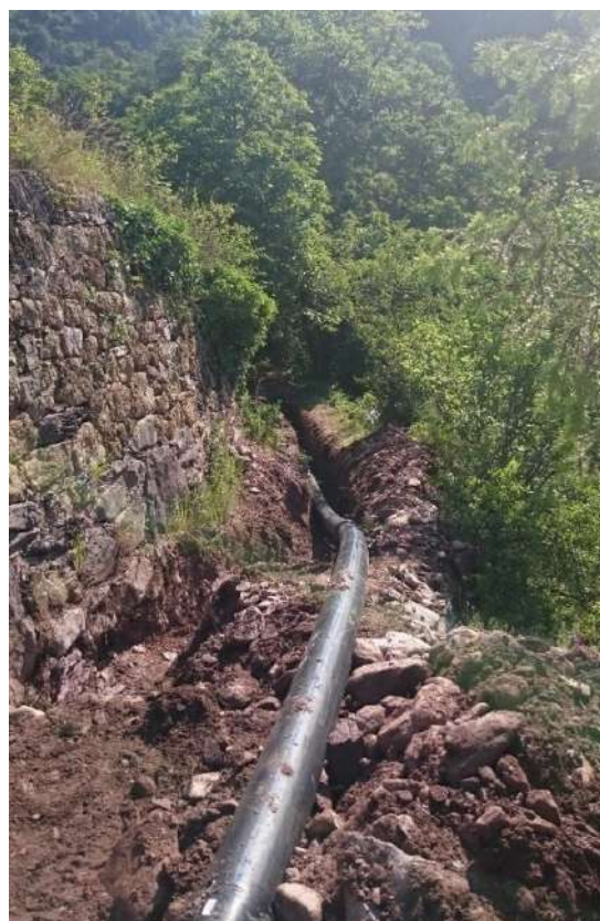
Travaux de pose de la conduite d'alimentation du hameau des vignes
