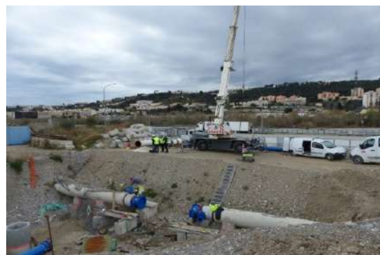
Préparation du raccordement du réseau de la traverse des Arboras au réseau existant
