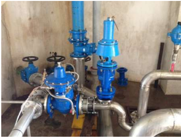
Installation d'arrêt de la surverse 1
