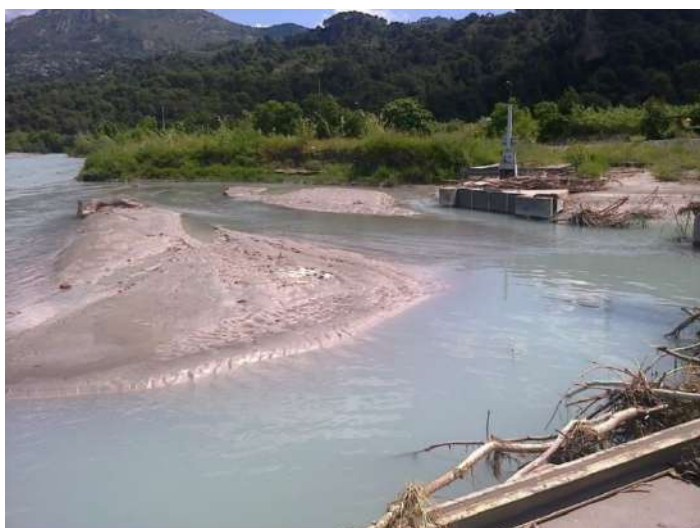
Essais géotechniques à proximité de la prise d'eau du Roguez
