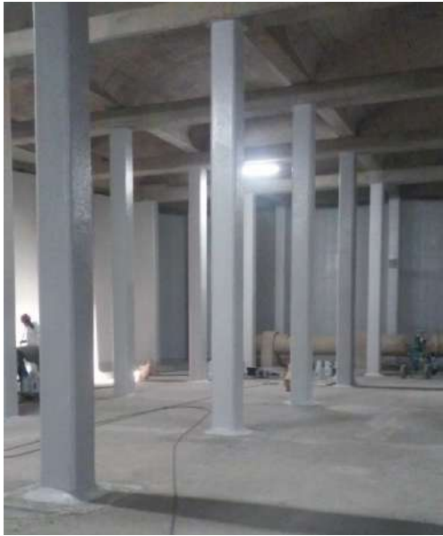
Réhabilitation du réservoir de Cap de Croix
