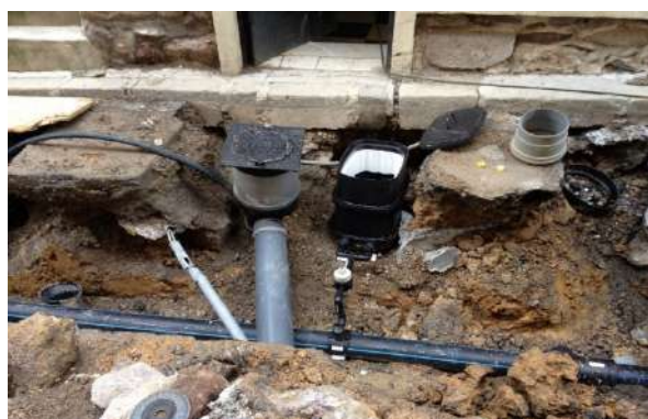
Pose de compteurs, renouvellements de branchements en plomb et changement de conduite
