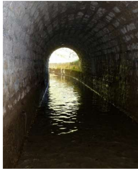
Tunnel de La Roquette sur le Canal de la Vésubie
