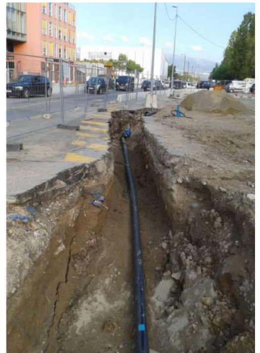
Travaux de déviation des canalisations
