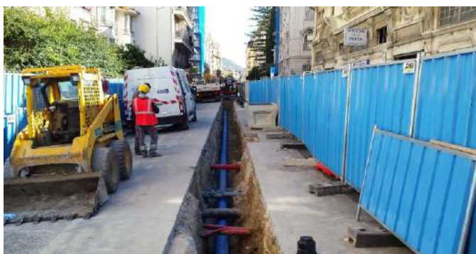
Travaux de dévoiement des canalisations
