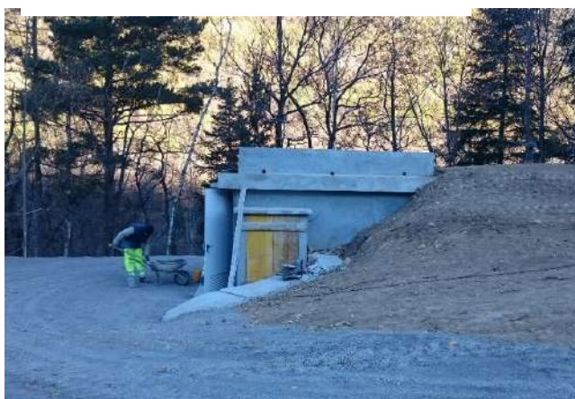
Chambre de vannes du réservoir
