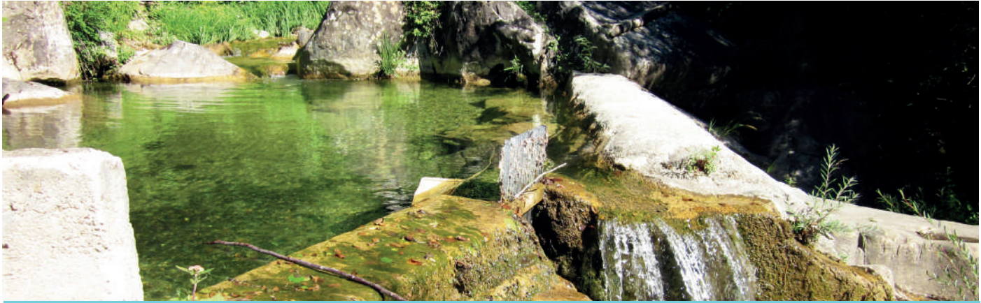
Prise d'eau du Riou (Lantosque)
