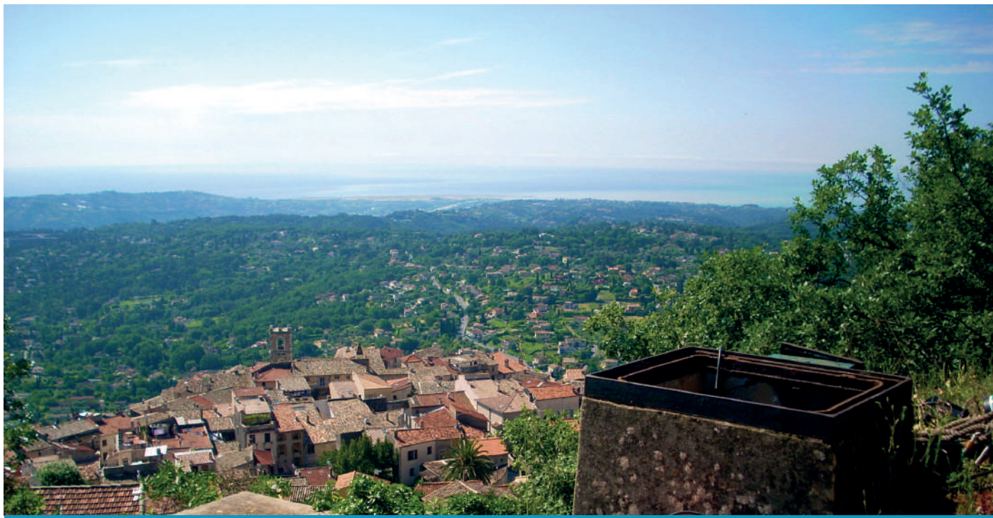
Réservoir Haut Village Saint-Jeannet
