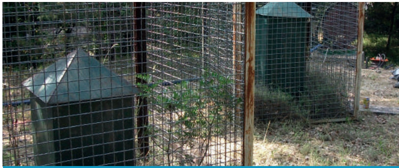
Réservoir du Mont Gros (La Gaude)
