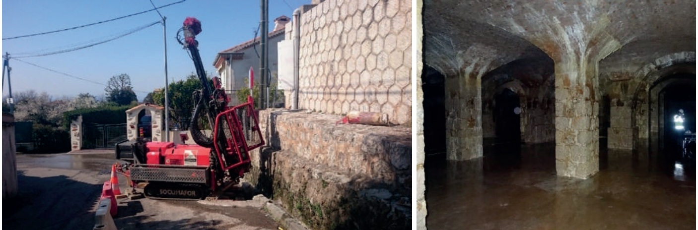
Jean-Favre : essais géotechniques pour l'étude de la réhabilitation des réserves d'eau potable et diagnostic de l'état de l'intérieur des réserves
