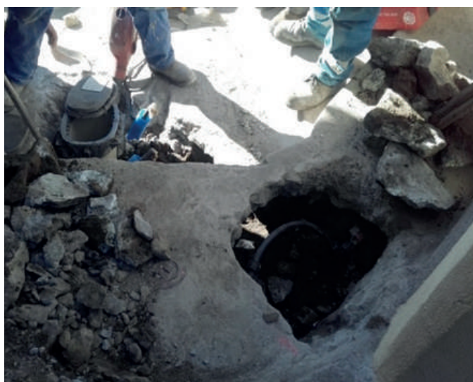
Restructuration des branchements existants pour la pose de compteurs individuels
