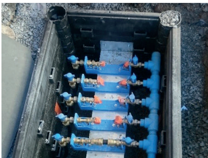
Bélvédère : Mise en place d'un abrimulti-compteurs
