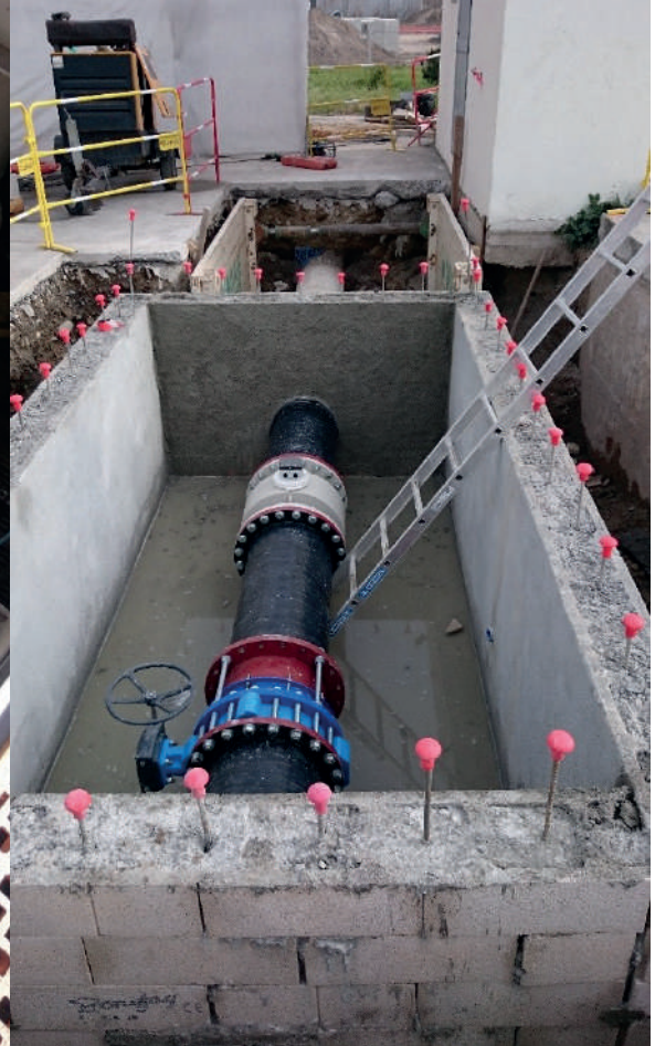
Mise en place d'une nouvelle pompe aux Prairies pour augmenter la capacité du champ captant.
