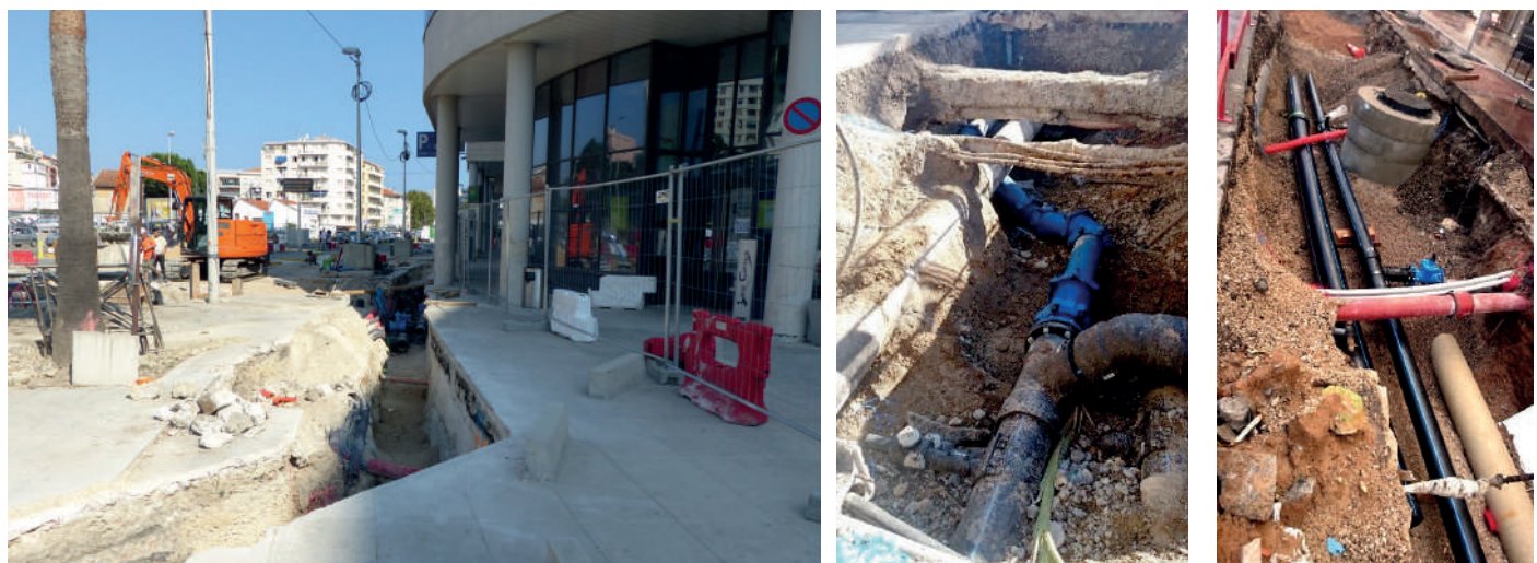
Travaux de dévoiement des canalisations
