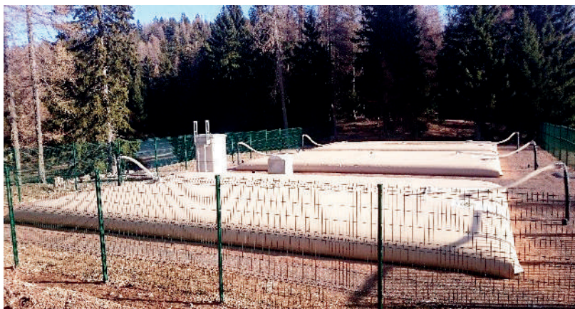
Création de réserves d'eau potable d'un volume de 450 m 3
