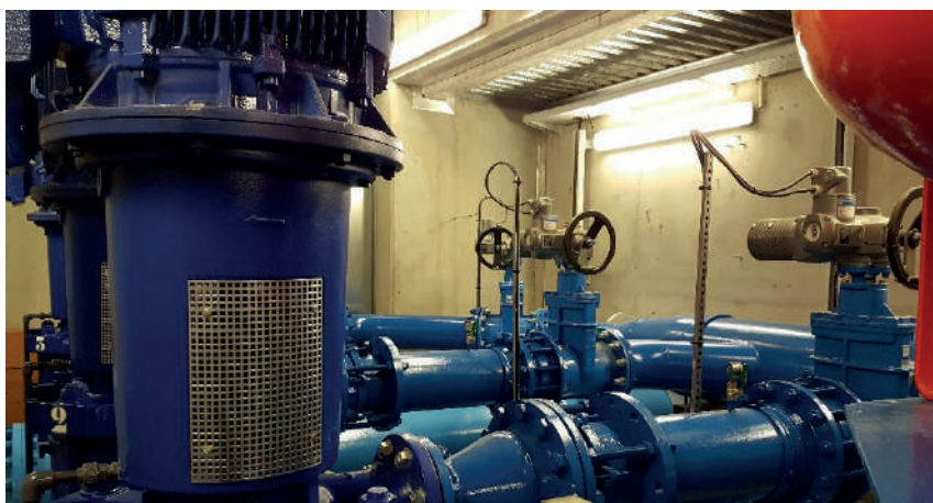
Mise en place des pompes dans la station Passerelle
