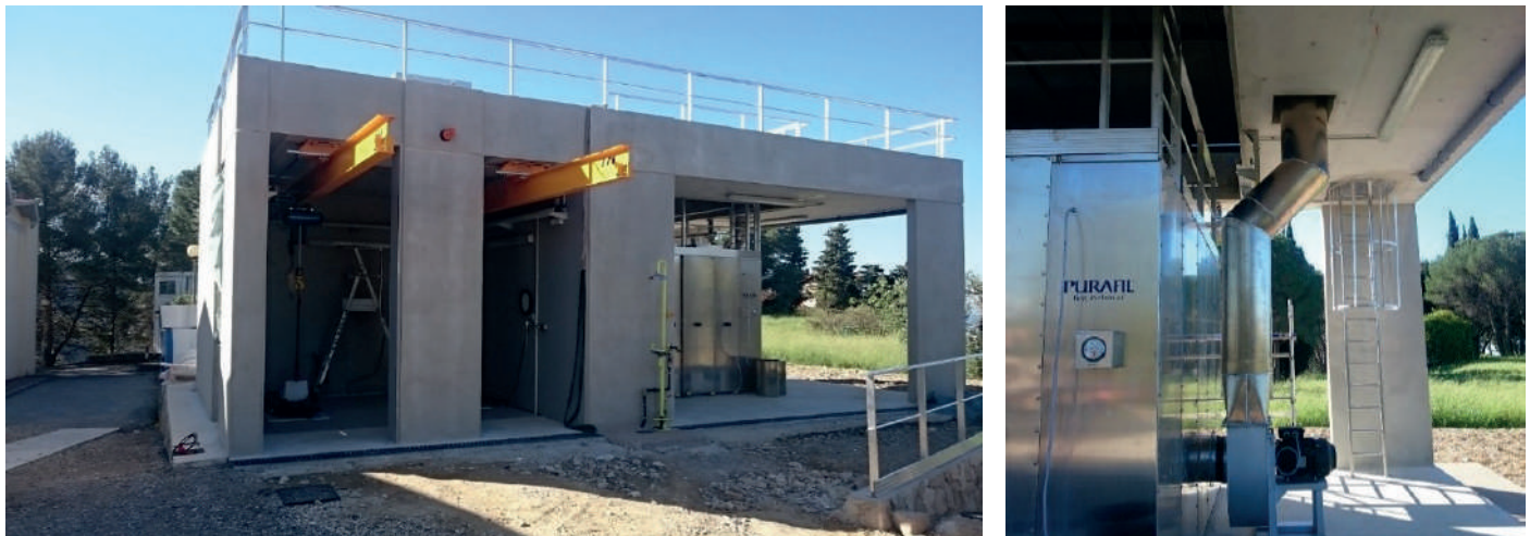
Façade principale de l'unité de déozonation en cours de construction Equipements en cours d'installation
